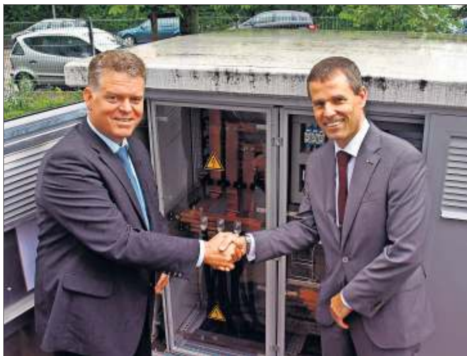
Michael Schober von Netze BW (l.) und Thomas Schäberle nehmen die neue Umschaltanlage in Betrieb, die zwei unterschiedliche Stromnetze verbindet. Foto: Leonie Schüler
